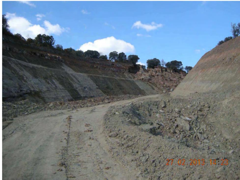
**Fotografía 7:** Filtraciones en la cara libre del talud en la zona no deslizada. Obsérvese que se producen en el plano de contacto entre las areniscas de cabecera y las lutitas subyacentes.
