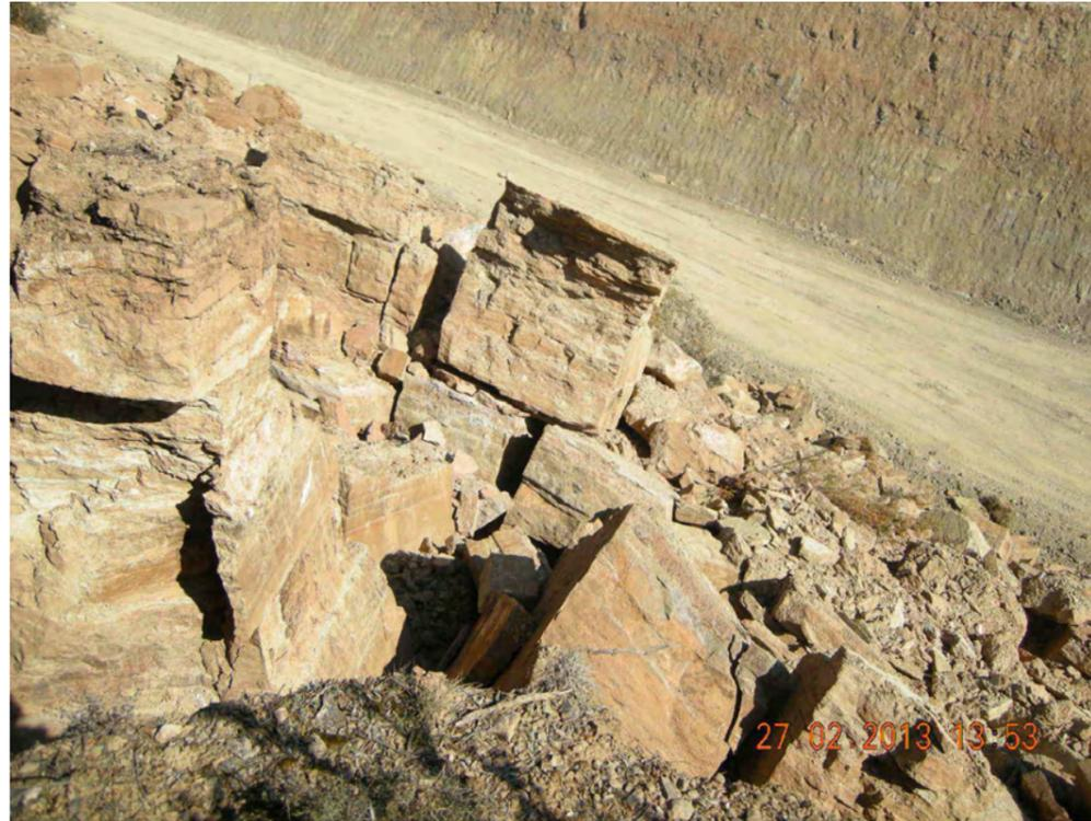
**Fotografía 28** Ejemplo de formación de cuñas E1-J2 en la cabecera del talud.
