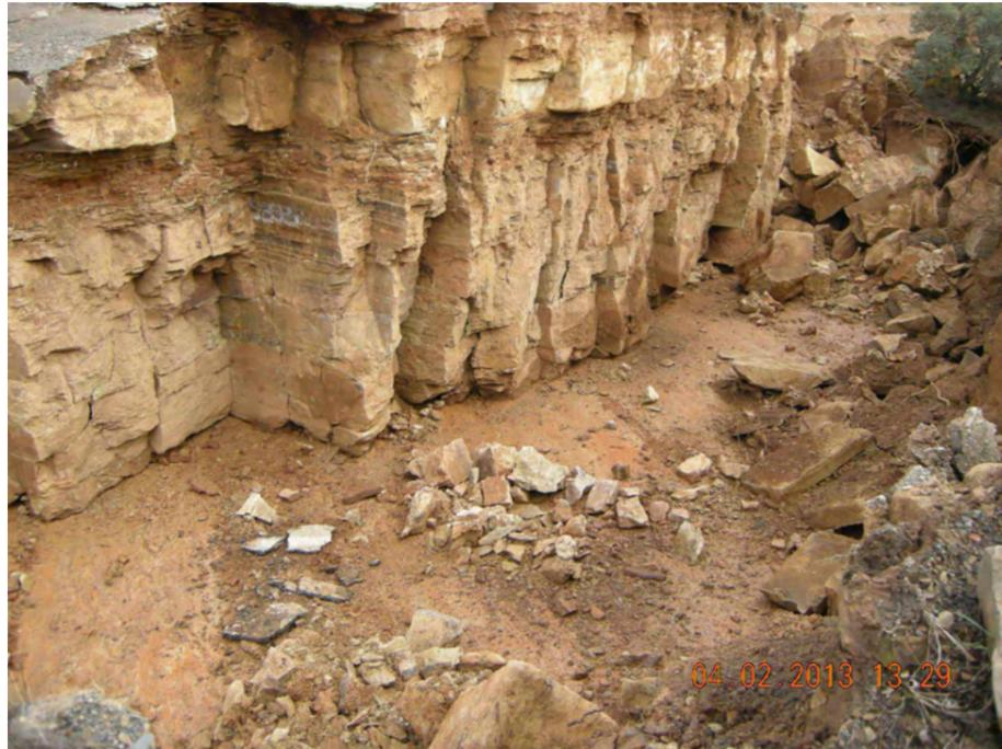
**Fotografía 28:** Planos de estratificación con buzamiento favorable a la rotura planar. Nótese el plano sobre el que se produjo del deslizamiento.
