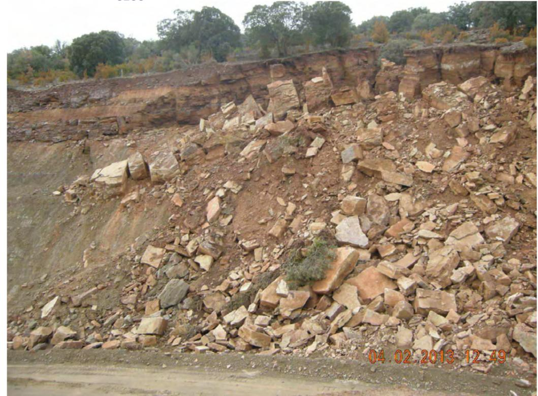
**Fotografía 24:** Aspecto general del macizo rocoso del talud deslizado. En cabeza de talud paquete de areniscas diaclasadas. A la izquierda plano de con las lutitas verdosas inferiores.
