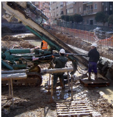
Perforación de anclajes.
