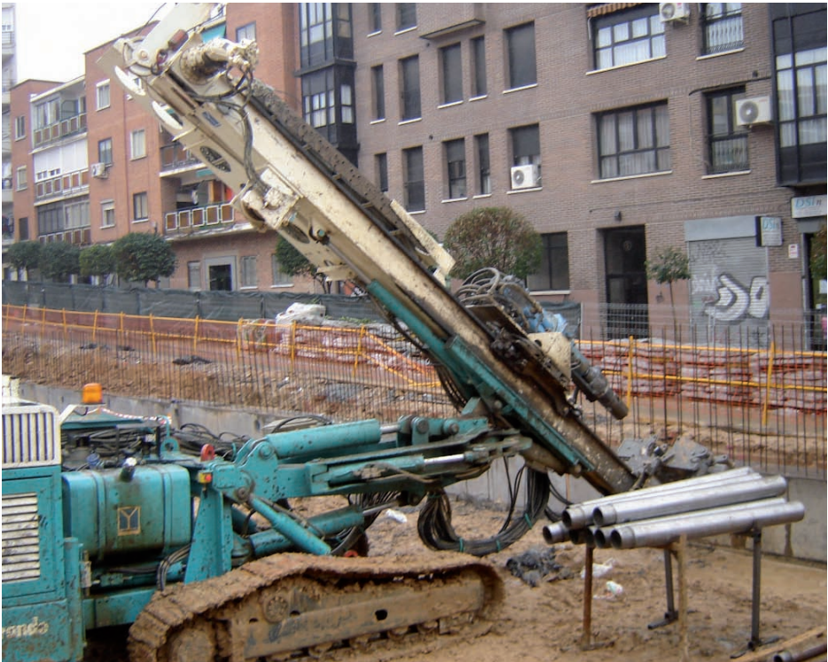
Equipo de perforación y utillaje en borriquetas.
