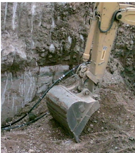
Preparación de la plataforma.
