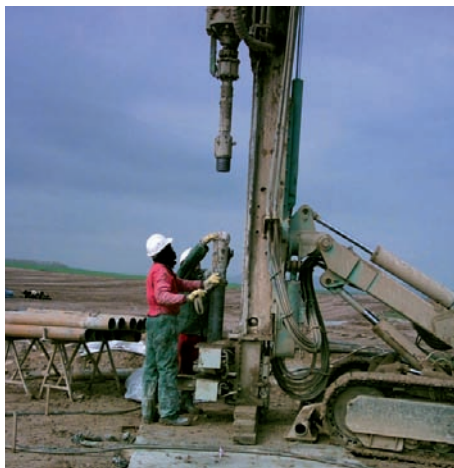
Introducción de la armadura.
