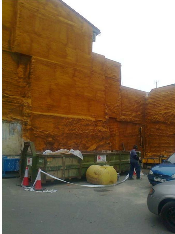
FOTO 3: Vista alzada de la posición de la penetración P-2, junto a la medianera de la fachada norte del solar.
