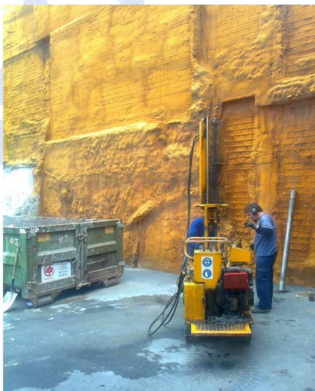
foto 2. Estado de la medianera con edificio en fachada norte
