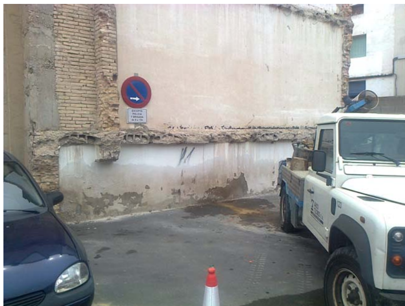
foto 1. Estado de la medianera con edificio en fachada este, donde se observan restos de un antiguo forjado a 1.40 m sobre la rasante actual del solar, lo que nos hace sospechar que en dicho solar, y junto a la medianera se han producido rellenos.
