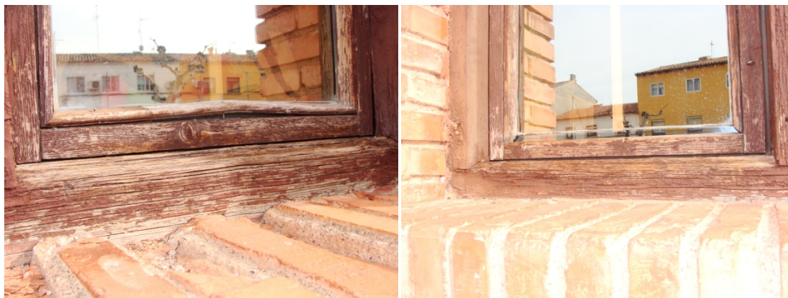
Imagen del estado general de carpintería exterior fachada sur
