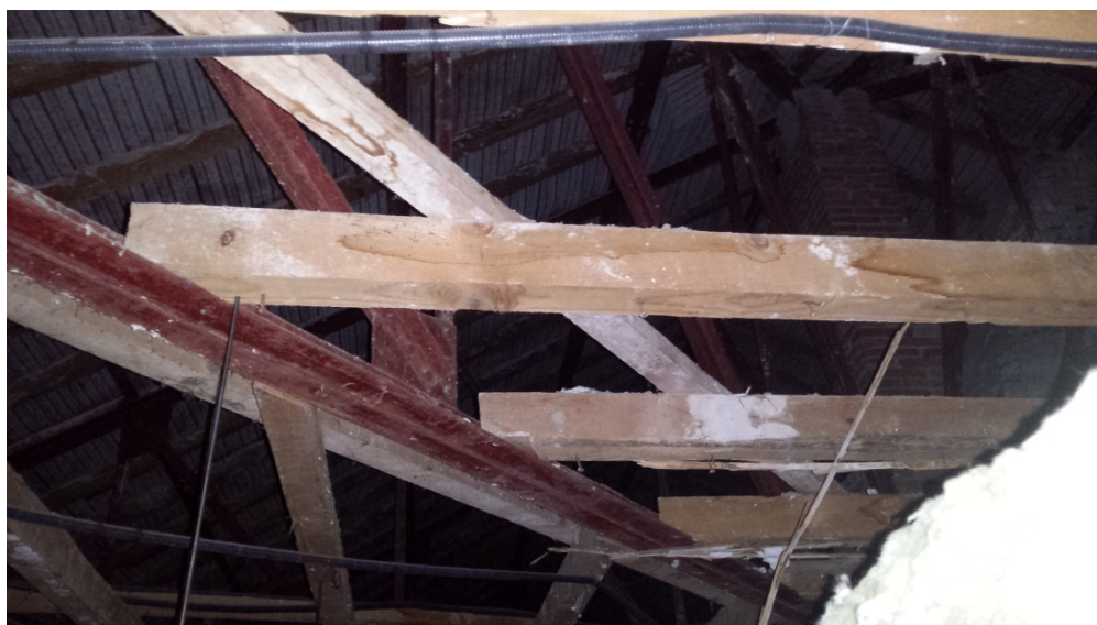
Imagen de estructura de tejado
