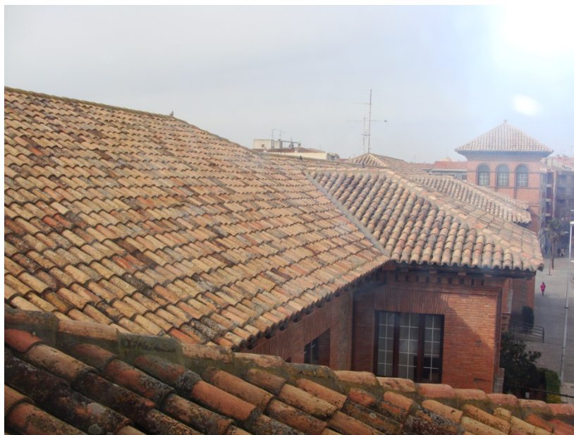
Imagen del estado del tejado
