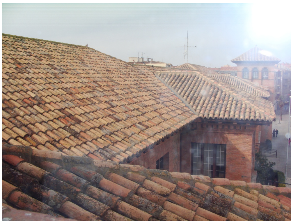
Cubiertas y torreón
