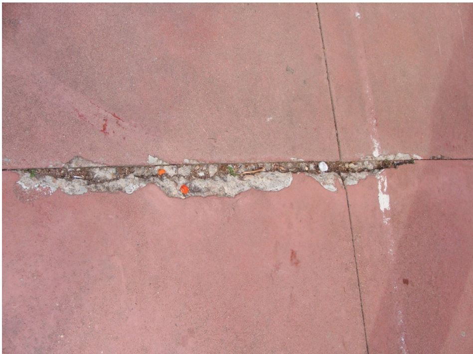
Imagen del estado del pavimento del patio
